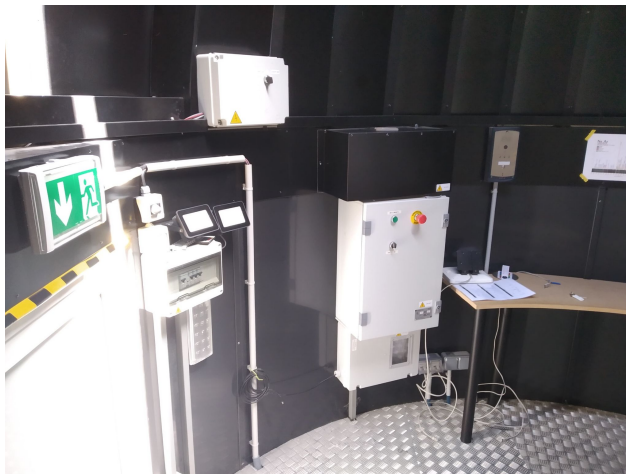
FIGURE 8 – L'intérieur de la coupole : commutateur d'éclairage à gauche après le signal d'évacuation lumineux, boîtier gris d'ouverture du cimier au-dessus à droite, et enfin à droite bloc électrique de contrôle de rotation de la coupole, avec prises en dessous.
